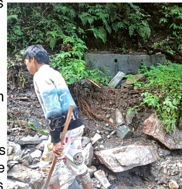
Réservoirs de captation endommagés
