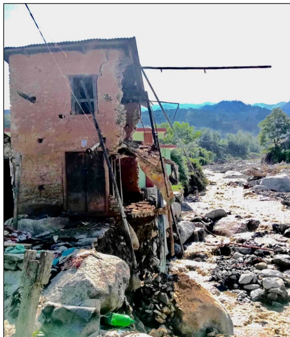
Maisons détruites par les eaux déchaînées
