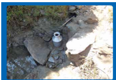
Tuyau amenant l'eau du bassin de recharge
