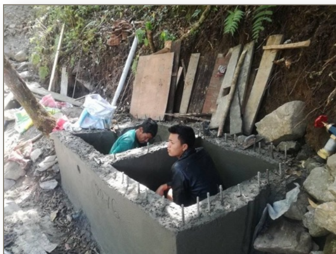
Construction du réservoir de captation pour Massarangue
