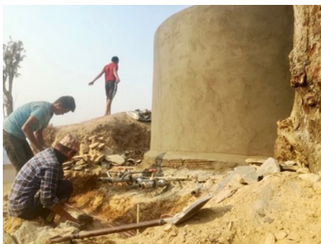
Construction du réservoir de stockage pour le village de Massarangue
