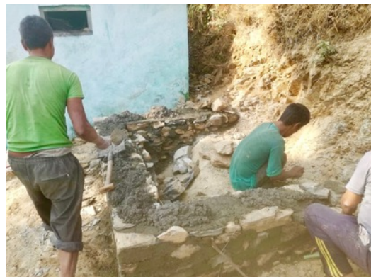
Construction du réservoir pour l'école de Massarangue
