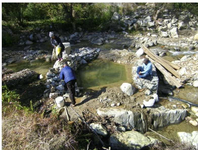
Construction du réservoir de captation pour quatre villages
